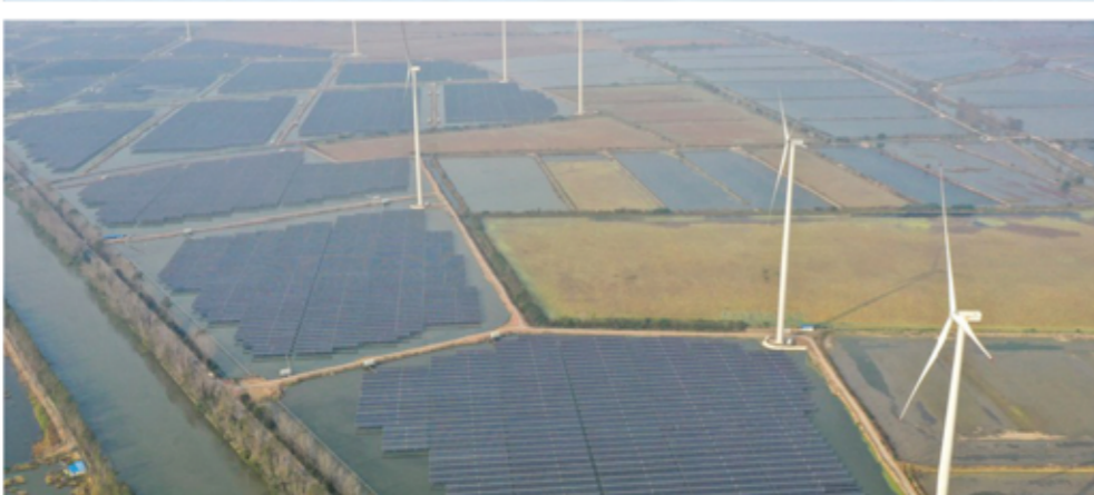
في الصورة الجوية الملتقطة يوم ٣ نوفمبر ٢٠٢١، مشروع توليد الطاقة الكهروضوئية وطاقة الرياح تم تركيبه فوق مصادب في مدينة يانغتشو بمقاطعة جيانغسو شرقي الصين (شينخوا)
